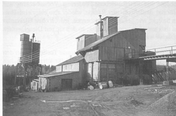
Tagesanlage, Zustand um 1970. An die Gleisbrücke anschließend das Mahlwerk, dahinter Absack- und Versandanlage. In den flachen Schuppen Magazin (vorn) und Werkstatt (hinten). Im Hintergrund die Siloanlage.
