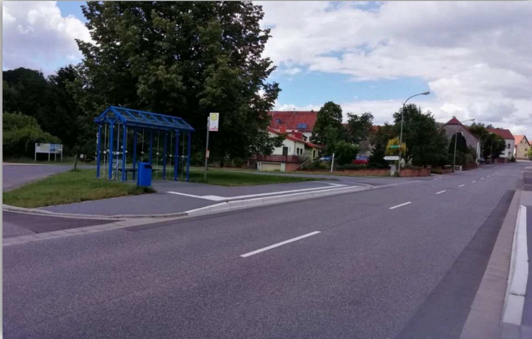
Abb. 16: Nonnweiler Dorfplatz, Beispiel einer barrierefrei ausgebauten Haltestelle, die den Mindestanforderungen genügt: Mast mit neuem Schild, Fahrplanaushänge, Hochbord, Taststreifen. Foto © ZPS, Markus Philipp.
