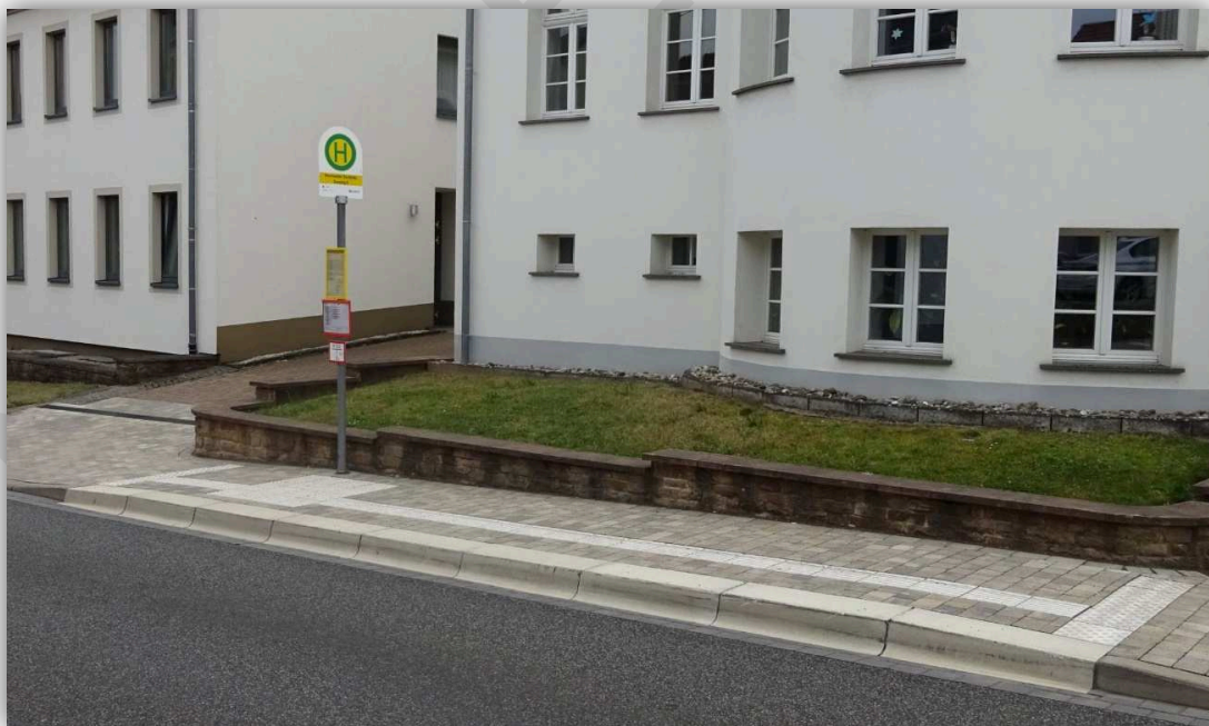
Abb. 16: Nonnweiler Dorfplatz, Beispiel einer barrierefrei ausgebauten Haltestelle, die den Mindestanforderungen genügt: Mast mit neuem Schild, Fahrplanaushänge, Hochbord, Taststreifen. Foto © ZPS, Markus Philipp.
