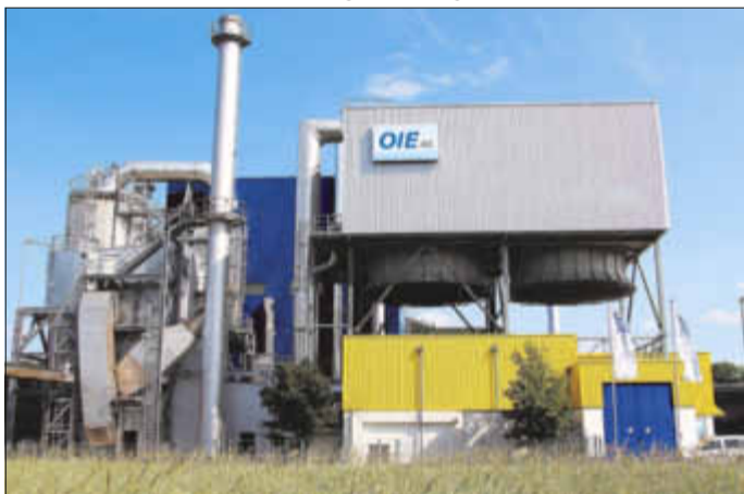
Die Heizzentrale der OIE in Idar-Oberstein. Foto: OIE
