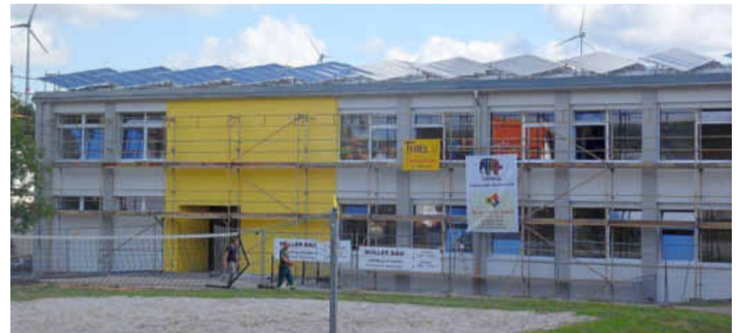
Energieeffizienz und Erneuerbare Energien auf einen Blick: Die Fassade der Gemeinschaftsschule Freisen wird gedämmt und erhält neue Fenster. Auf dem Dach wurden Solarmodule montiert und im Hintergrund sind die Windkraftanlagen der Freisener Höhe zu sehen. Foto: pdk
