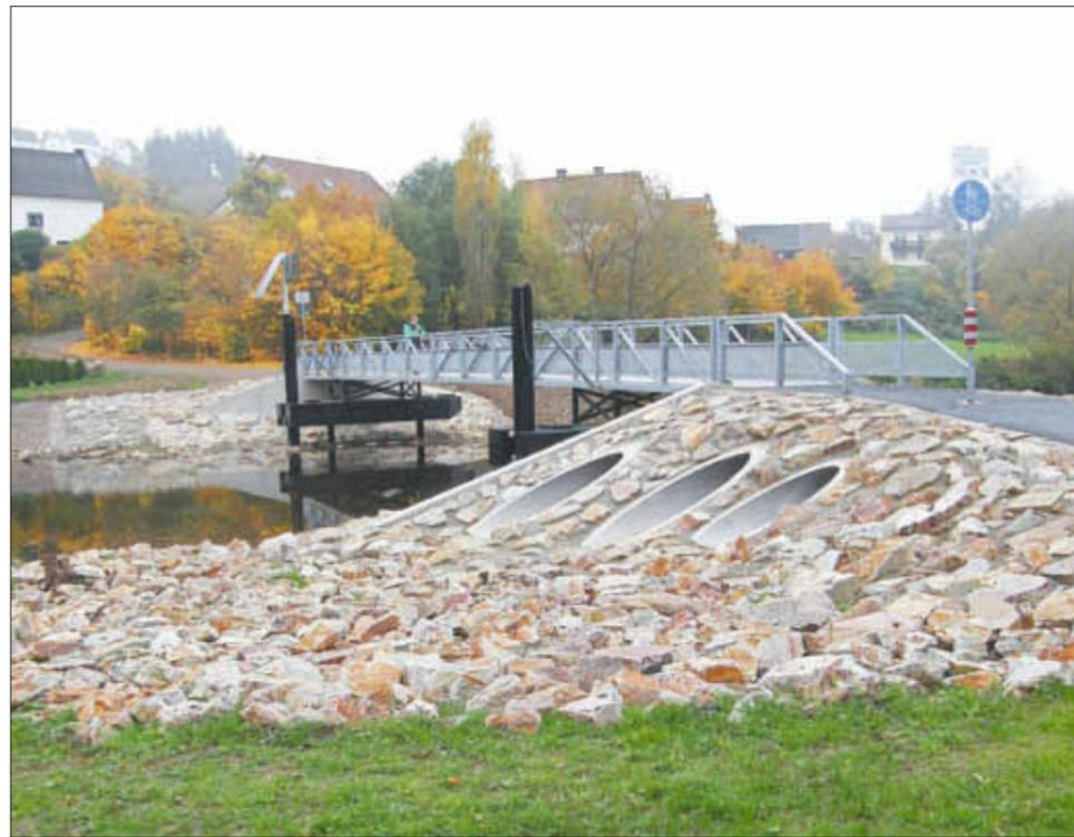
Die neue Nahe-Radweg-Brücke zwischen Enzweiler und Hammerstein ist ganzjährig befahrbar. Bei Hochwasser heben zwei Pontons die Konstruktion an und das Wasser kann ungebremst darunter durchfließen. Foto: Schultheiß
