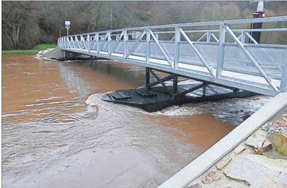
Die Strömung drückt, wie das Foto zeigt, den Bug des Schwimmkörpers der neuen Nahebrücke nach unten, das Heck steigt hoch, wodurch sich die Fahrbahn der Brücke neigt. Foto: pdk
