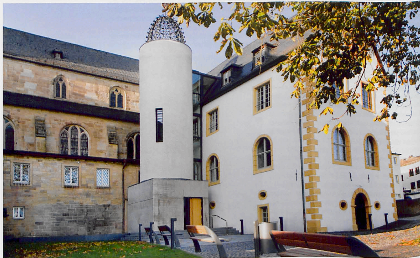
Kapitelsaalbau mit neuem Treppenturm
