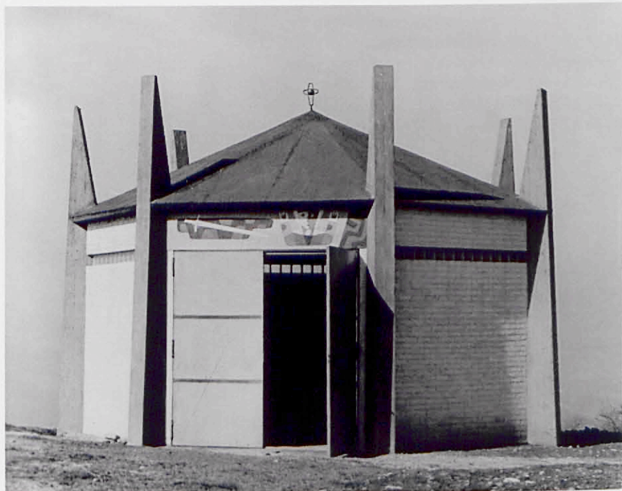
Kapelle im Urzustand der Erbauungszeit
