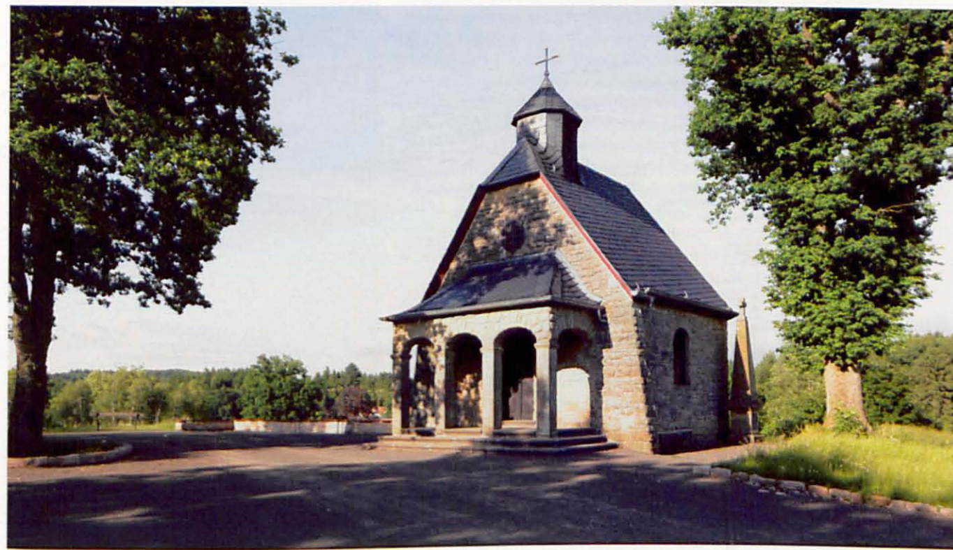
Die sanierte Kapelle mit neu gestaltetem Umfeld 2009
