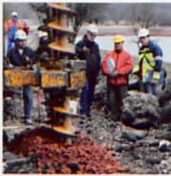
Erdarbeiten an der Stauwehr
