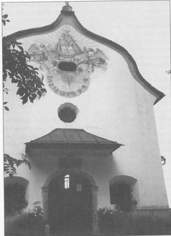
Wallfahrtskirche „Mariae Heimsuchung auf der Brettfall“ in Strass am Eingang des Zillertals
