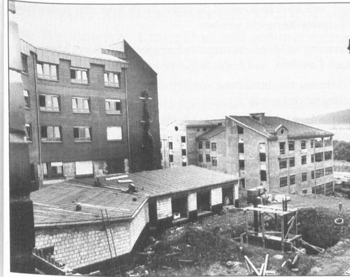
Am Marienkrankenhaus entsteht ein modernes geriatrisches Rehabilitationszentrum als Modellprojekt.
