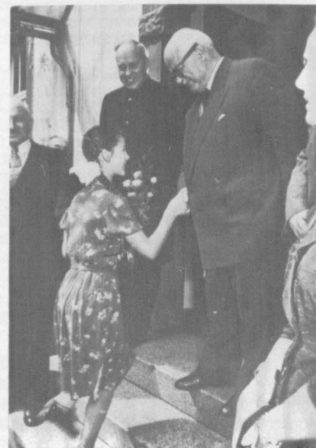
1953: Ministerpräsident Johannes Hoffmann besucht das Hospital. Neben ihm Dechant Johannes Barth und Bürgermeister Jakob Fuchs. (Anlaß des Besuchs war die Fertigstellung des 1. Bauabschnittes des Kleinkinder- und Krankenneubaues).
