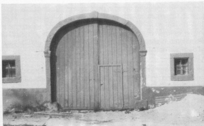
Scheunentor, 1830 Remmesweiler, Auf der Hell
