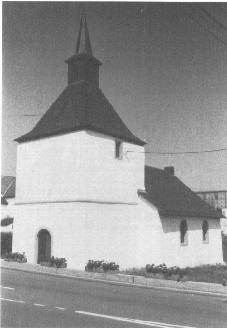
Abb. 1, Außenansicht der Selbacher Katharinakapelle, Zustand: 1986
